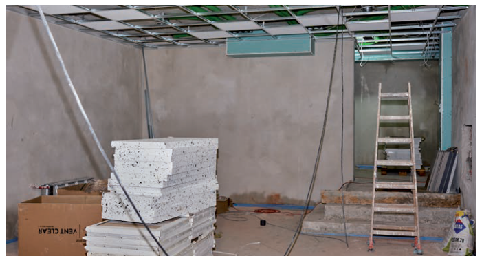
Remont pomieszczeń przeznaczonych na Strzelnicę
