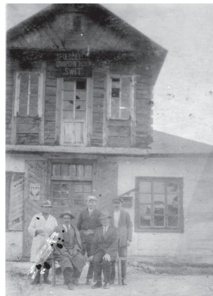
Stara, drewniana remiza strażacka, w miejscu obecnej remizy w Otrocz.
